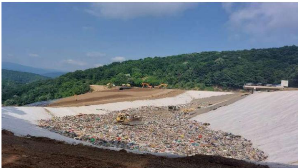
Слика 4.4.1. Санитарна касета на општинској депонији
