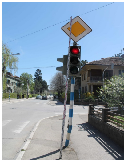
Фотографија 1. Оштећен стуб светлосне саобраћајне сигнализације
