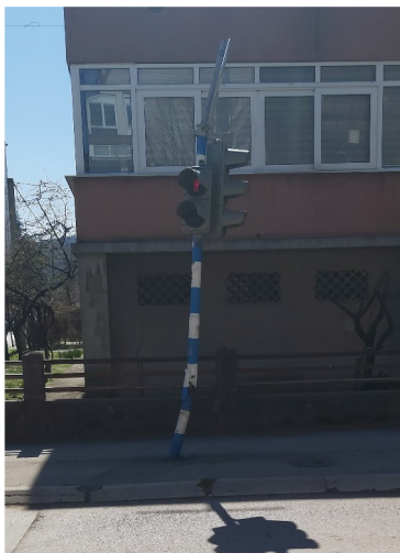
Фотографија 2. Ошћећен стуб светлосне саобраћајне сигнализације (из другој ула)
